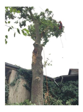
Die Seilklettertechnik ist eine perfekte Lösung für schwer zugängliche Fällungen. Dort wo kein schweres Gerät, oder Hebebühne, zum Einsatz kommen kann, ist dies die einzige Lösung, um Bäume sicher abzutragen.
